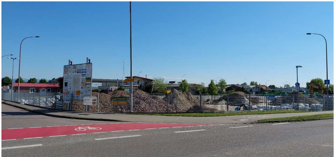
Blick von Norden (Riegeler Straße) nach Süden über das Planungsgebiet
